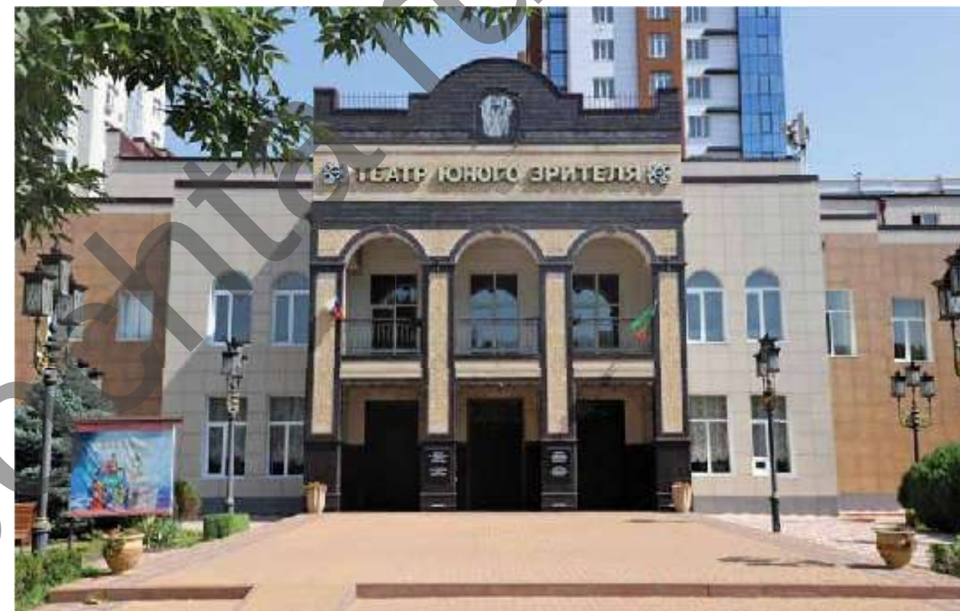
Отреставрированное здание Театра юного зрителя. Открытие восстановленного театра состоялось в 2008-м году.
