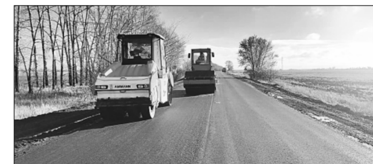
Весной дорожки проведут второй этап ремонта
